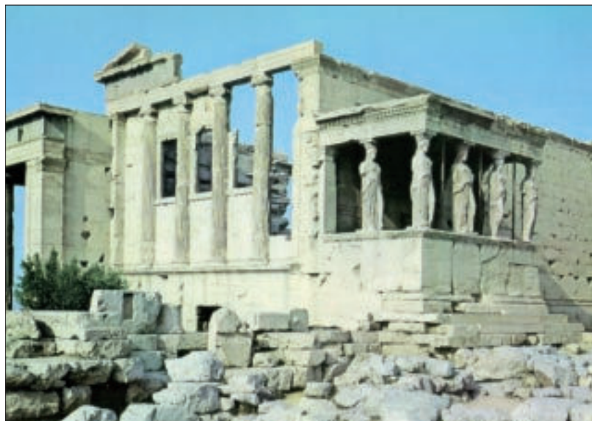
«Ερέχθειον». Ιωνικός ναός με ιδιόρρυθμο σχήμα και περίτεχνη διακόσμηση. Είναι ιδιαίτερα γνωστός από τις Καρνάτιδες, τα αγάλματα δηλαδή των γυναικείων μορφών που λειτουργούν σαν κίονες στηρίζοντας τη στέγη της νότιας προεξοχής του οικοδομήματος. Η κατασκευή του ολοκληρώθηκε προς το τέλος του Πελοποννησιακού πολέμου (405 π.Χ.).
